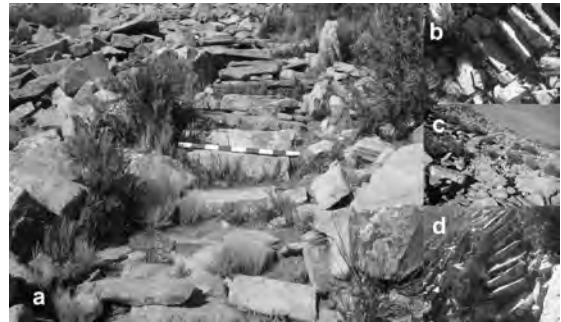
Fig. 27. Tramos del Qhapaq Ñan en el ascenso al santuario de altura del Cerro Sixilera. a) Escalonado ancho con mojoneros laterales. b) Escalonado regular. c) Enlajado. d) Escalonado fino.
