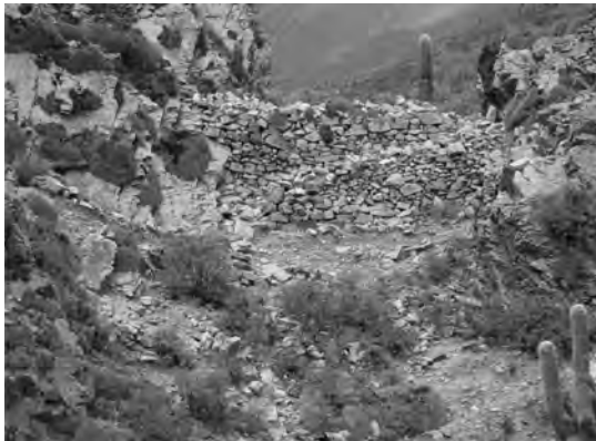
Fig. 6. Rampa de acceso al sitio, confeccionada con grandes bloques dispuestos a manera de piso.
