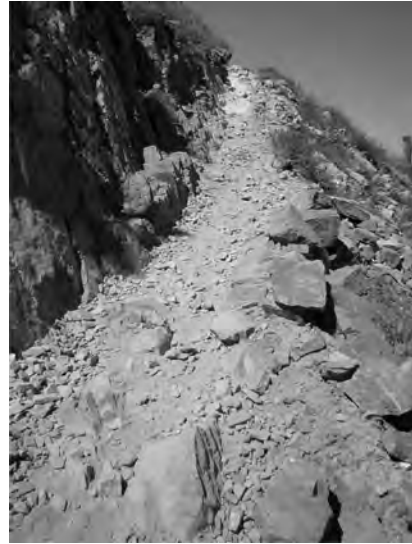
Fig. 24. Tramo de camino incaico con muros de retención lateral, actualmente en uso.
