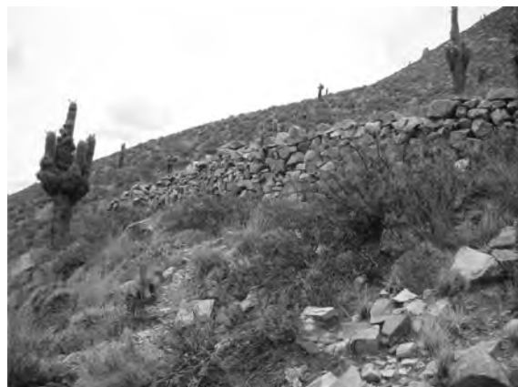
Fig. 19. Banqueta de refuerzo identificada en el Morro 2 del Peñón de la Huerta.
