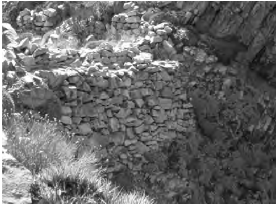
Fig. 5. Banqueta perimetral construida para reforzar el muro oriental del Recinto N°1.
