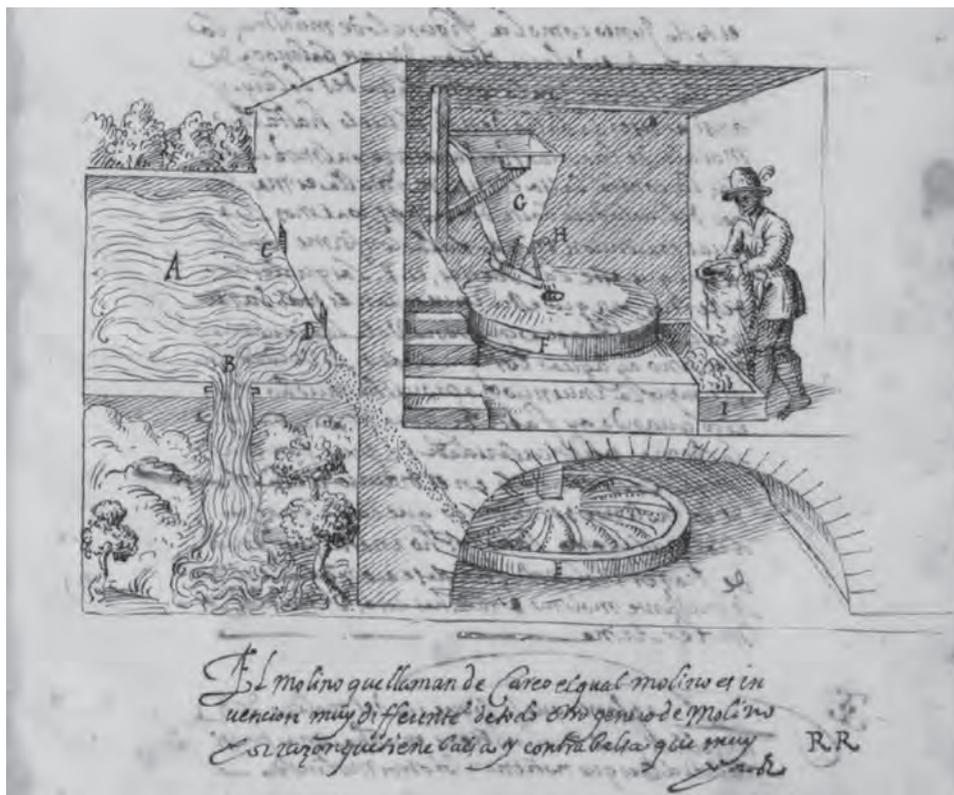
Fig. 1. Molino hidráulico de rodezno horizontal. Diseño del siglo XVI.
