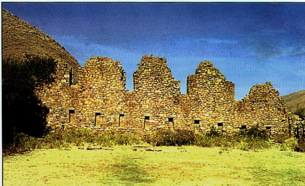
Bien conservado sector del Muro defensivo
