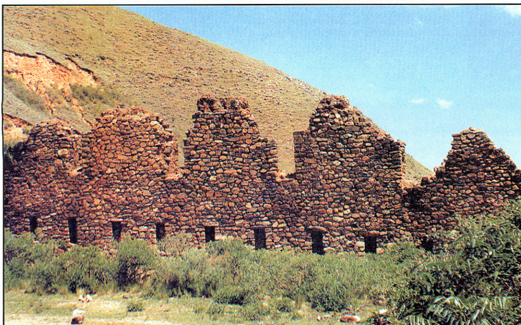
Vista Muro Este de la Kallanka
