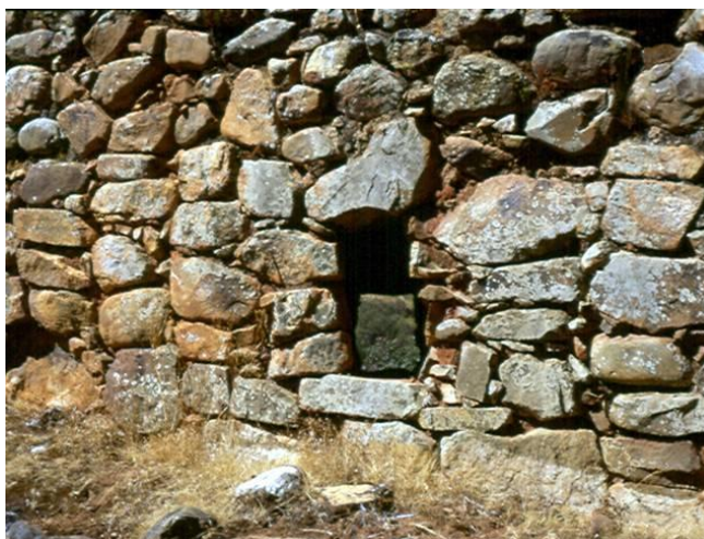
Figura 33. Detalle de tronera en el muro periférico.
