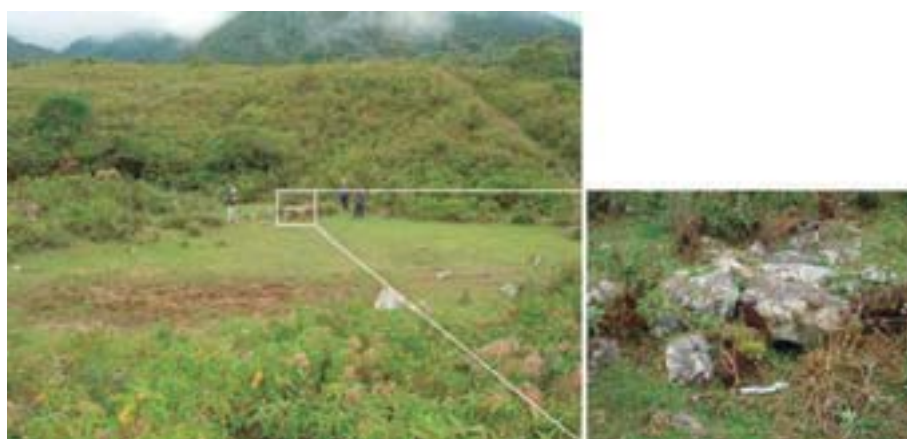
Fig. 5.81. A la izquierda: La qocha y el lugar por donde sale el canal que conduce el agua de la vertiente. A la derecha: Detalle de la boca del canal hecho de piedra (Fotos: Marcos Bustamante).
