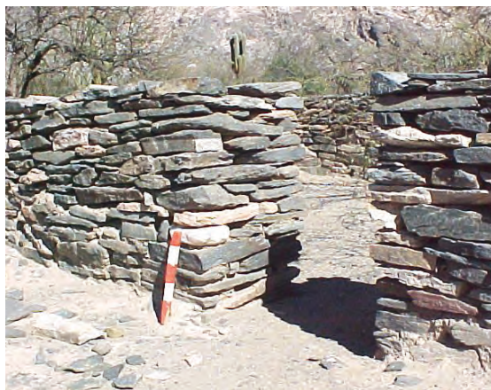
Fig. 8. Detalle constructivo del muro de una de las estructuras del sector Inca del sitio de Fuerte Quemado-Intihuatana.
