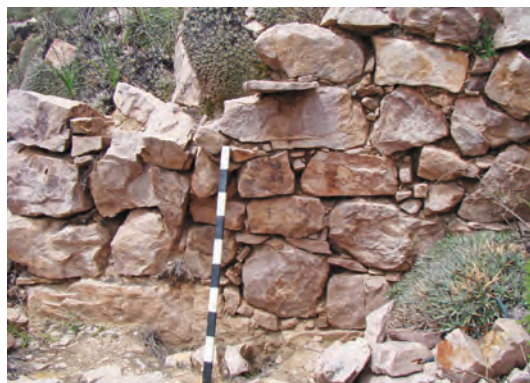
Fig. 12. Muro canteado de forma regular construido en cuarcita rosada.
