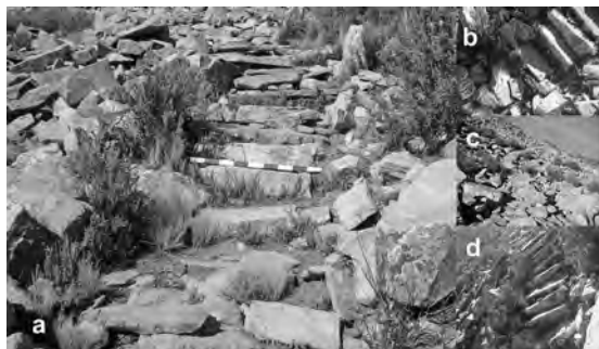
Fig. 27. Tramos del Qhapaq Ñan en el ascenso al santuario de altura del Cerro Sixilera. a) Escalonado ancho con mojones laterales. b) Escalonado regular. c) Enlajado. d) Escalonado fino.
