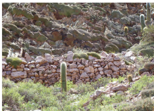
Fig. 13. Detalle de las cuatro grandes piedras planas colocadas verticalmente a manera de troneras de defensa. Una quinta roca se encuentra derrumbada en el extremo derecho de la imagen.
