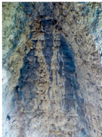
Figura 11. Detalle de la superficie interior de la falsa bóveda. El acabado pulido presenta manchas negras.
