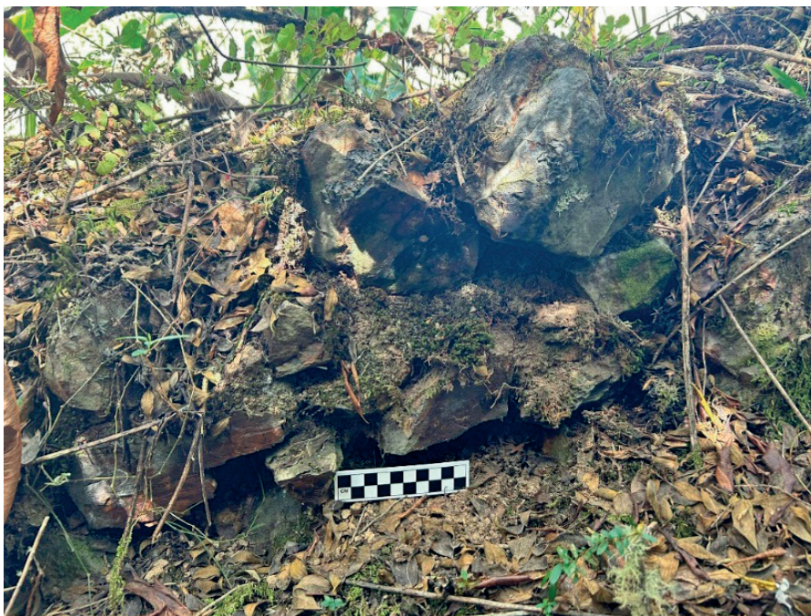
Figura 8. Detalle de la mampostería de piedra del muro.
