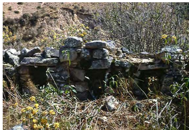
Foto 5. Inca Huayco, puesto de control del agua.
