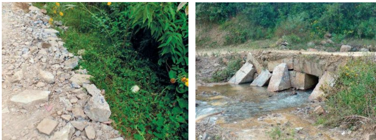
Figura 16. Izq. Ripiado del camino con desechos de sodalita. Der. Fundación de puente de sodalita.
