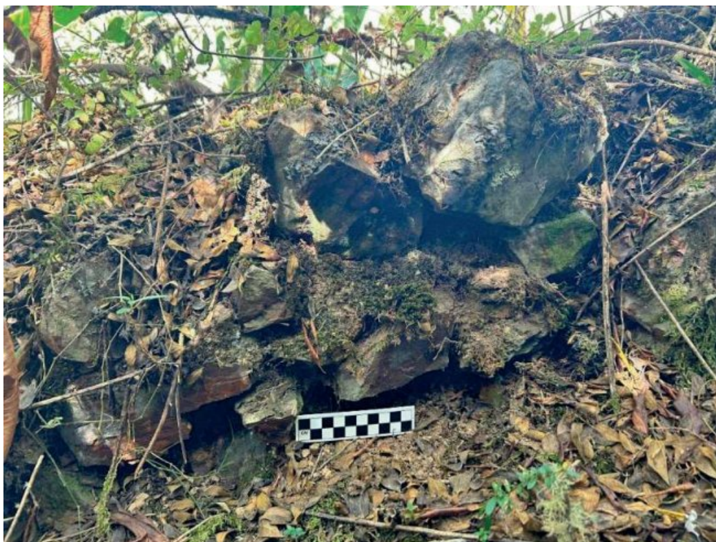
Figura 8. Detalle de la mampostería de piedra del muro.
